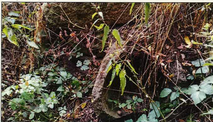
Ulomené výústění propustku Pr2 do svahu
