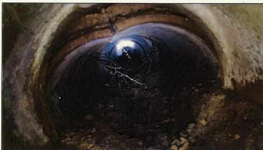
Porušený a zanesený propustek Pr1
