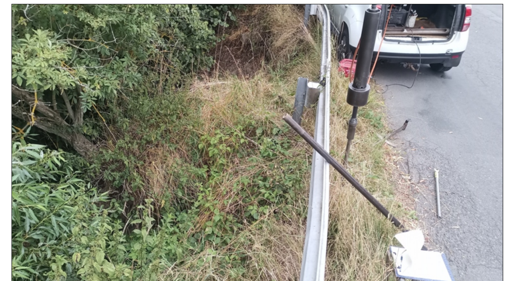
Foto č.6 : Svahové deformace za svodidly v blízkosti penetrační sondy DP2
